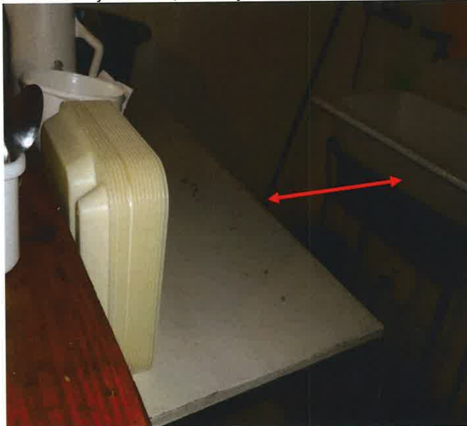
Jardín infantil Rayito de Sol; mesón y lavadero sin cubierta anti oxidable
