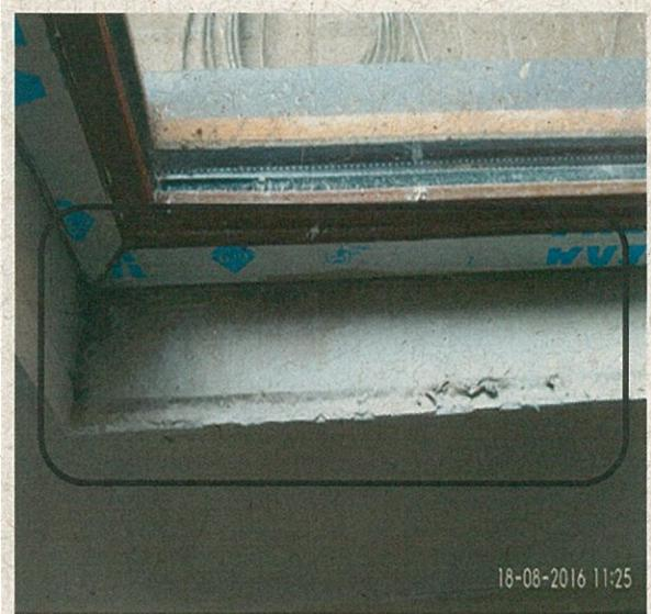
Fotografía N° 4: Vano de ventanas sin sobremarco de madera.
