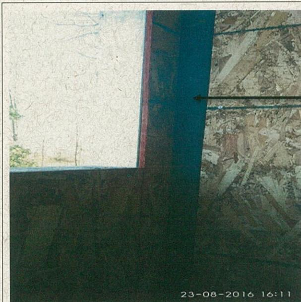
Fotografía N° 13: Vista de estructura metaliza sin pintura intumescente.
