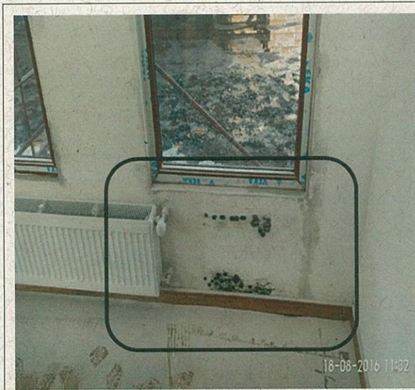
Fotografía N° 5: Humedad en muros.
