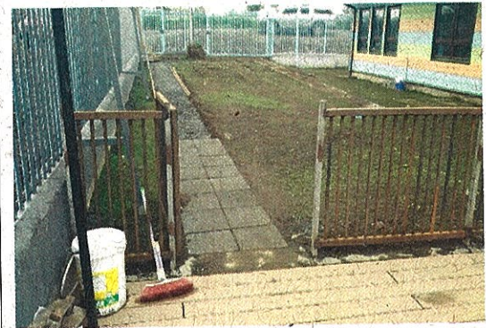
Fotografía N° 4: Detalle de puerta salida a patio con una hoja.
