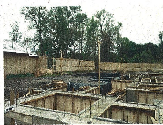
Fotografía N° 16: Vista exterior "Diseño especialidades y ejecución de obras Jardín San Pedro".
