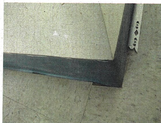
Fotografía N° 8: Vista nivel de piso terminado y guardapolvo.
