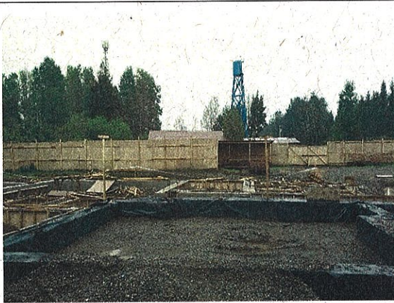
Fotografía N° 15: Vista exterior "Diseño especialidades y ejecución de obras Jardín San Pedro".
