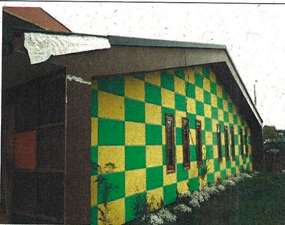
Fotografía N° 9: Vista exterior "Diseño especialidades y ejecución de obras Jardín Calle Osorno".
