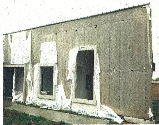
Fotografía N° 14: Vista exterior "Diseño especialidades y ejecución de obras Jardín El Llolly".
