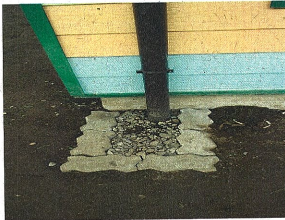
Fotografía N°1: Bajadas de aguas lluvias con fijaciones de PVC.
